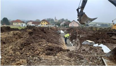
Im Herbst wurde in der Siedlung in Frauendorf der Schmutzwasser- und der Regenwasserkanal, die Wasserversorgung sowie EVN- und Telekom-Leitungen und Lichtwellenleiter (Glasfaserkabel) verlegt.
