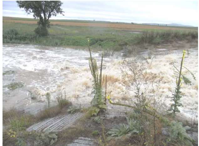
Überlauf des Rückhaltebeckens Roseldorf
