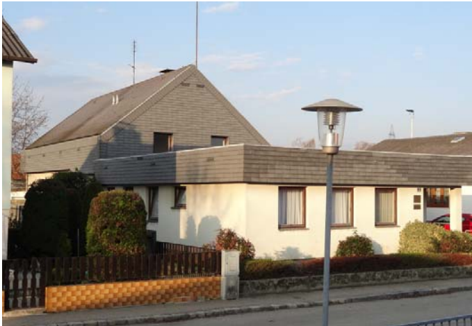
Arzthaus vor der Sanierung im Frühjahr 2012
